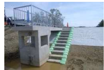
ため池改修工
