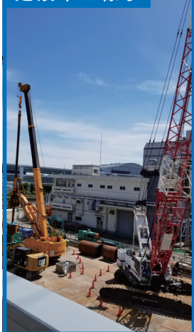
建設中の様子
