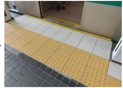
▲隙間・段差解消後
