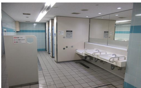
▲名谷駅トイレ高質化工事(工事前)
