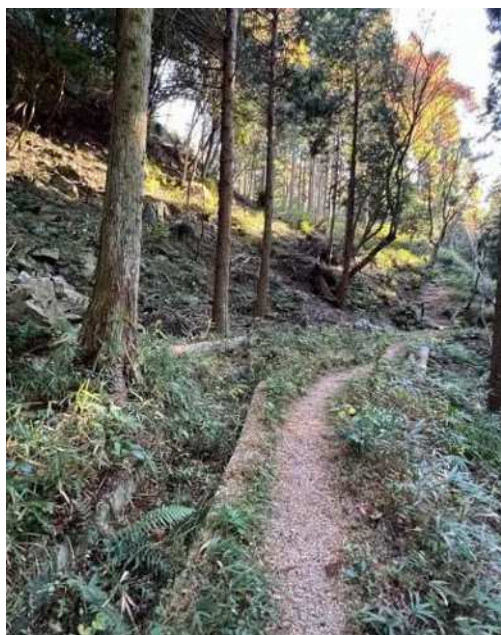
現況写真：導水路
