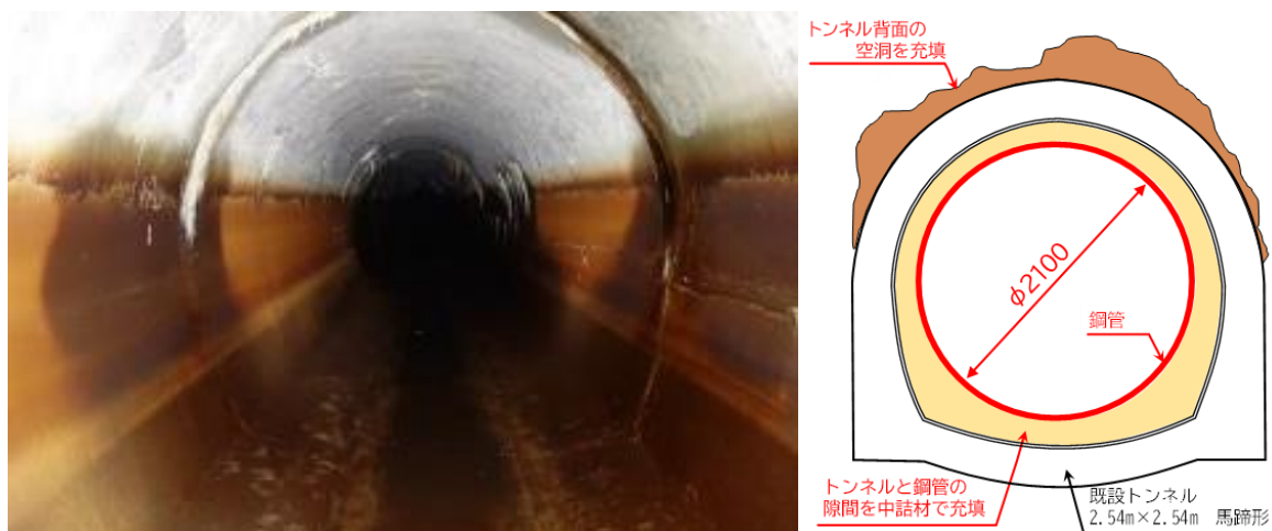
4 拡送水トンネル
