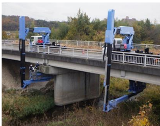
橋梁点検車による点検
