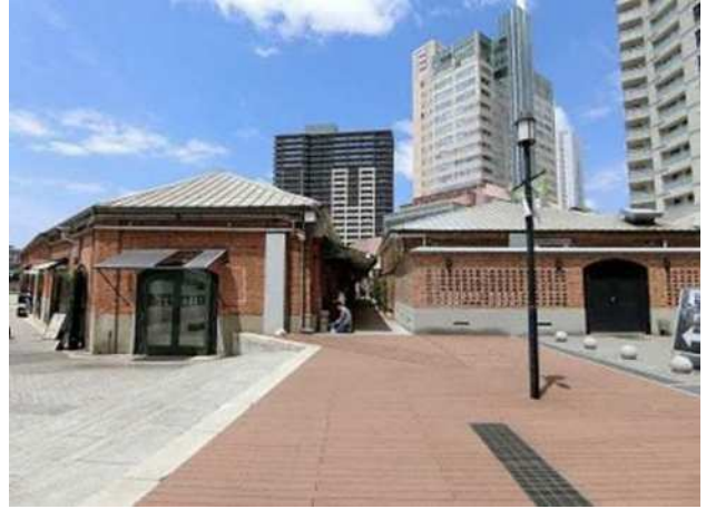
2. 北棟と南棟(東から)
