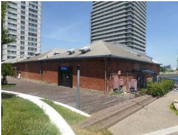
9. 南棟西～南面(南西から)
