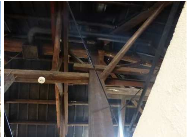
10. 南棟小屋組(部分)
