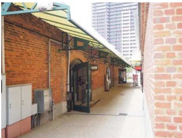
5. 2棟間の路地(東から)
