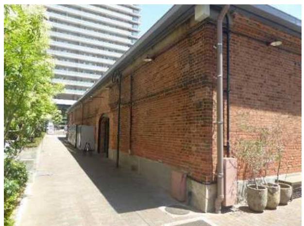
4. 北棟北面(北西から)
