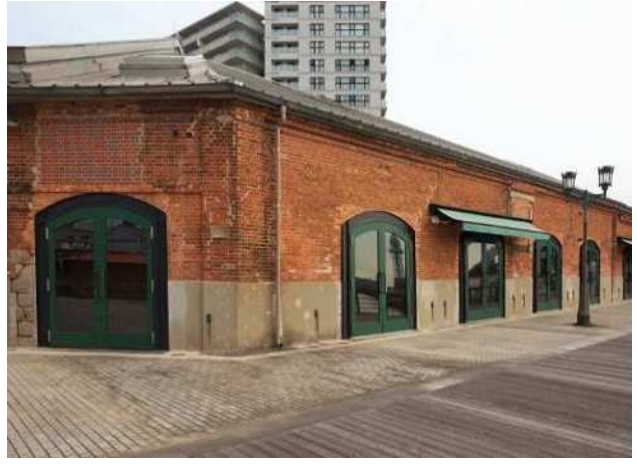
8. 南棟東面(南から)
