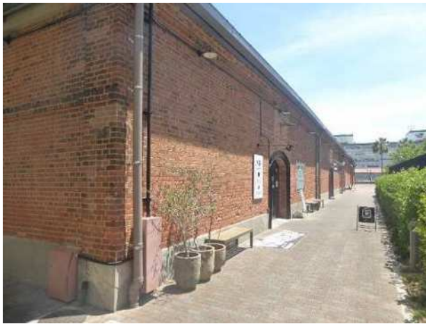
3. 北棟西面(北西から)
