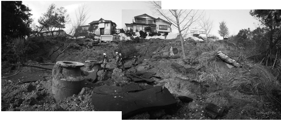
写真－２ 2004年中越地震による腹付け盛土の被害
