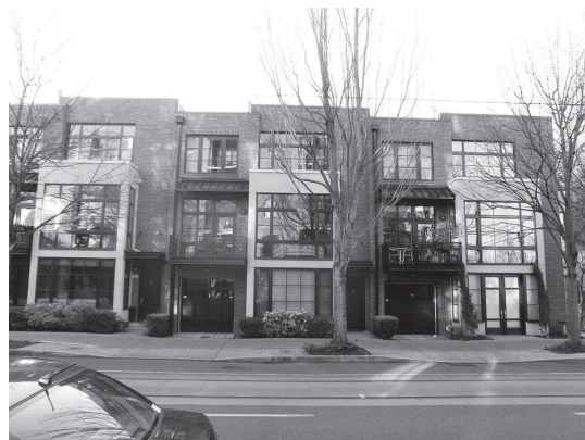
写真5 リノベーションによる商業施設 (Patagonia も入居)
