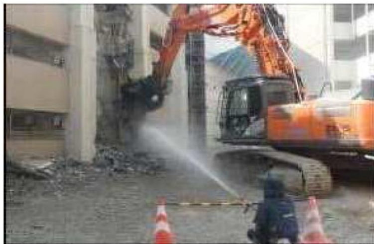
躯体解体時の散水
