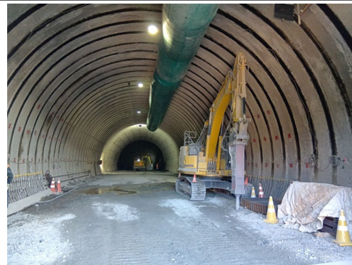
④ 支保工二次吹付コンクリート施工状況
