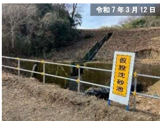
仮設沈砂池の設置
