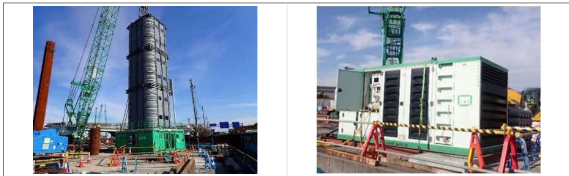
図 5-9 建設機械の稼働状況（左：油圧パイルハンマ、右：油圧ユニット）
