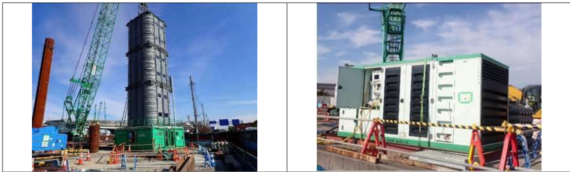
図 5-3 建設機械の稼働状況（左：油圧パイルハンマ、右：油圧ユニット）
