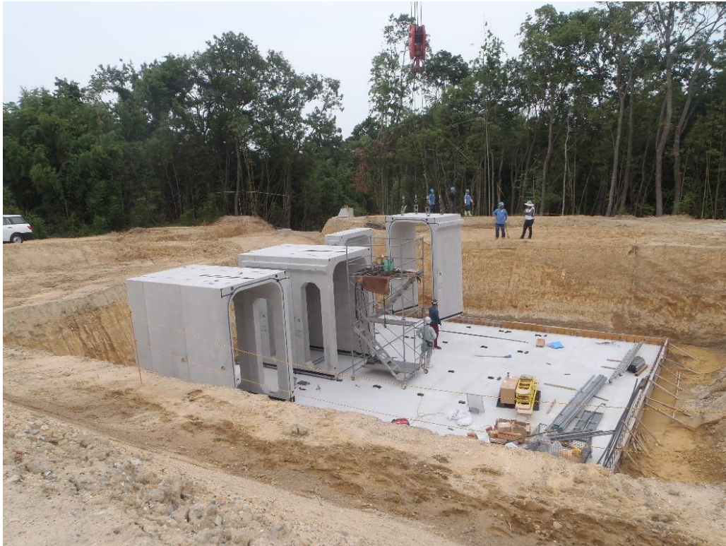
▶雨水貯留槽設置 | 押部谷町公園
