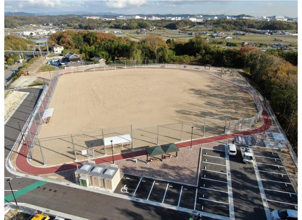
▶公園整備後 | 押部谷町公園
