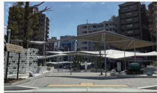
灘駅（南側）整備後
