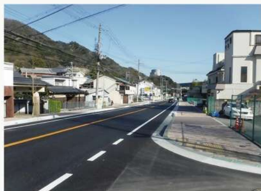
垂水妙法寺線 整備後
