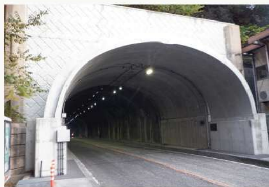
トンネル補修(鉄拐山トンネル)
