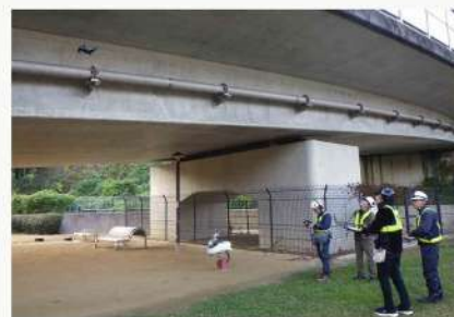
ドローンを活用した橋梁点検
