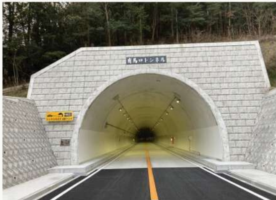
有馬トンネル整備後
