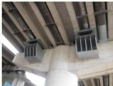
橋梁耐震補強(樺谷第一大橋)
