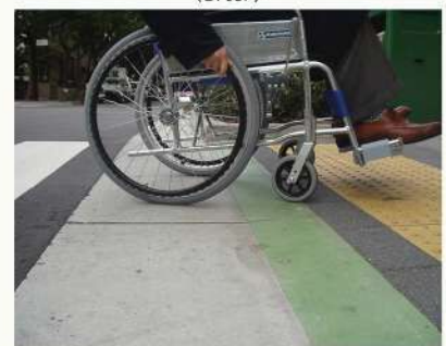
歩道の段差解消
