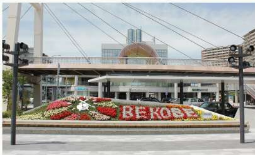
西神中央駅（西側）整備後
