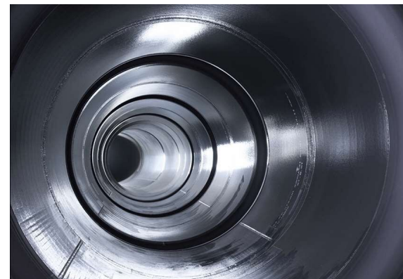
大容量送水管の内部(直径2.4m)
