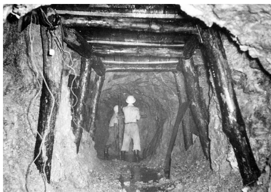
3 拡送水トンネルの掘進状況
