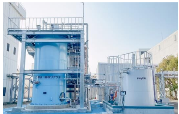
リン回収設備（西区 玉津処理場）
