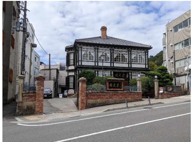
敷地東側から主屋、附属屋、南側はなれを見る。敷地は煉瓦塀で囲まれ、南北2か所の出入り口には花崗岩の門柱が残る。
