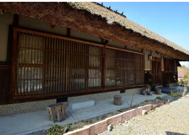
主屋カミノマ、シモノマ座敷前の軒下空間。縁側は内縁、濡れ縁ともに無い。改修前は座敷の東側正面から南側に回り込んだ奥行きのある浅い濡れ縁があった。
