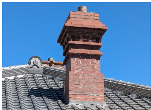
屋根は和型いぶし瓦葺。煉瓦造の煙突3本を現在も確認することができる。
