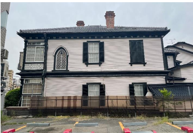
開口は、主要な室において上げ下げ窓・鎧戸を持つ。尖塔アーチを持ったステンドグラスの開口の外部底には装飾的なバージーボードが付く。
