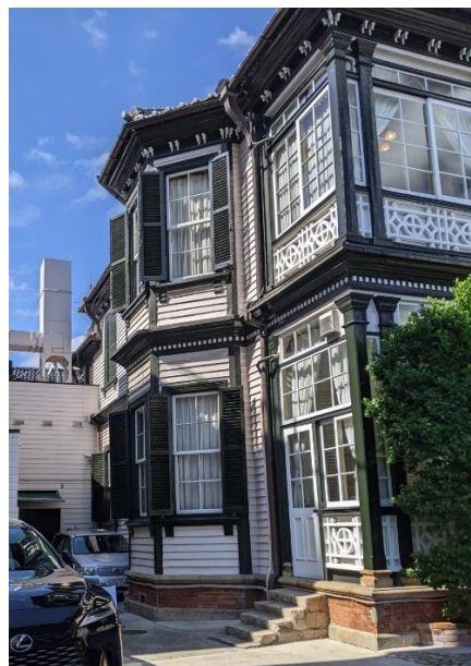
敷地南東側から主屋、南側はなれを見る。外壁は、隅部を定規柱で押さえるイギリス下見板張りのペンキ塗り。
