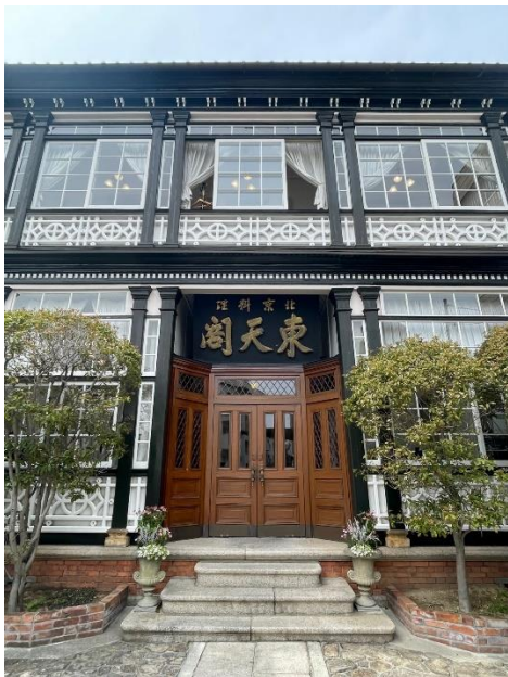
前庭から建物主屋を見る。東面が1、2階ともガラス窓を入れたベランダとなっており、建具は引き違いで、玄関周りの建具と共に後付けと思われる。
