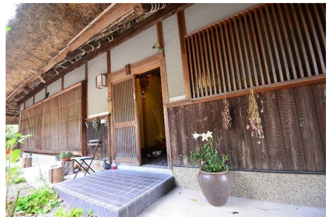
格子のある窓や玄関戸、板張りの腰壁など意匠に拘って改修されており、大きな茅葺屋根とともに伝統的な風情を漂わせる。
