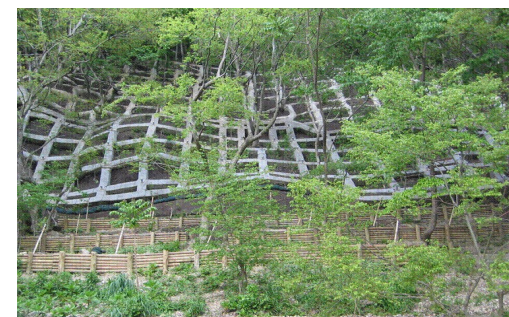
現存植生を保全した法枠工
