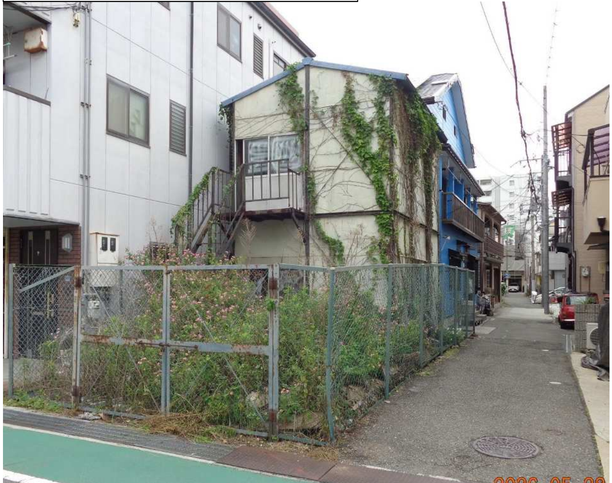
対象地側面（南）より撮影
