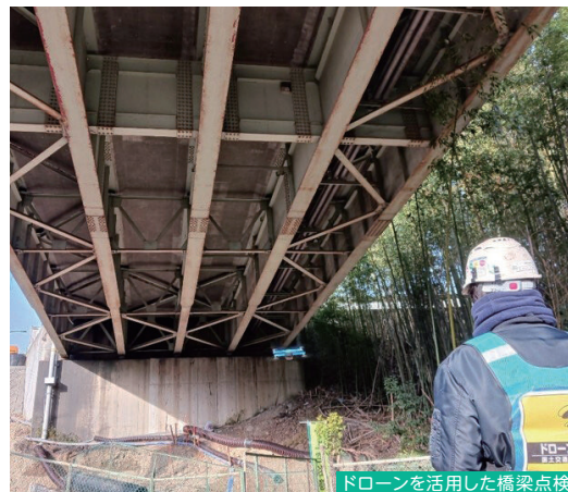
ドローンを活用した橋梁点検
