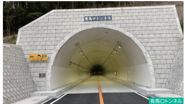
有馬ロトンネル
