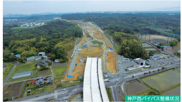
神戸西バイパス整備状況
