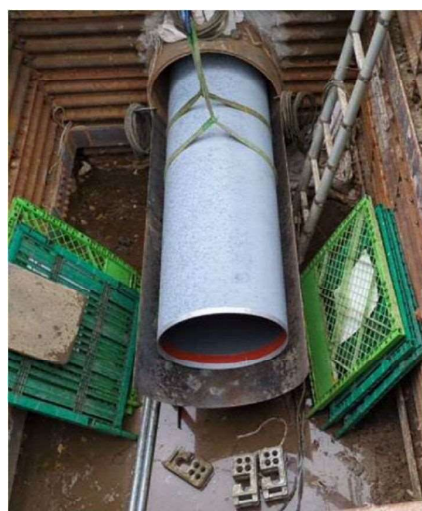
配水管更新工事 (ダウンサイジング) (既設管φ900内にφ700新設管を挿入)
