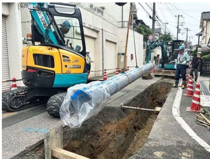
配水管更新工事 (開削)
