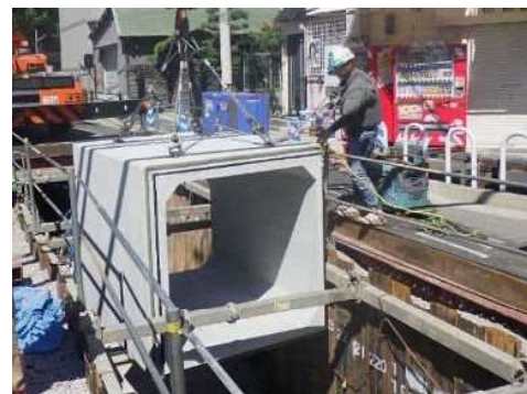
内水圧対策としてボックスカルバートへの改築
