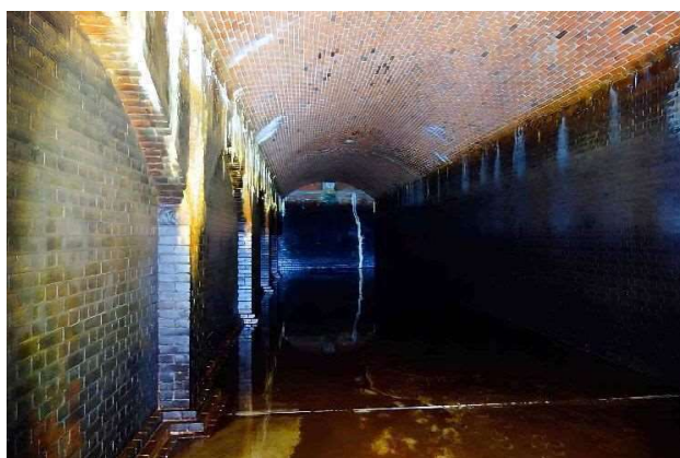
奥平野低層配水池
