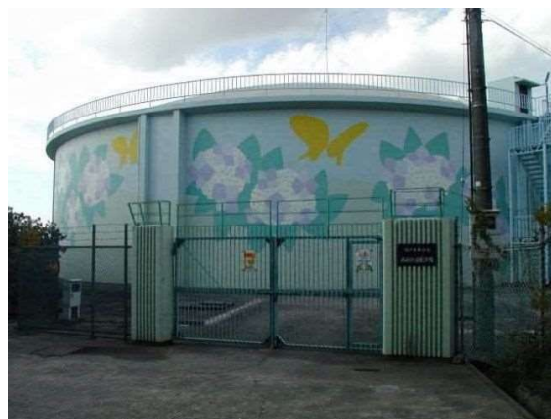
西神低層配水池
