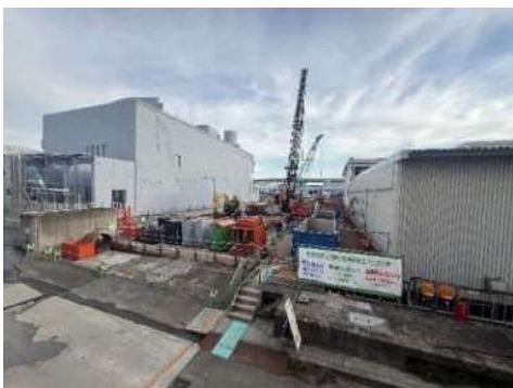
魚崎ポンプ場改築更新事業（第2期）
