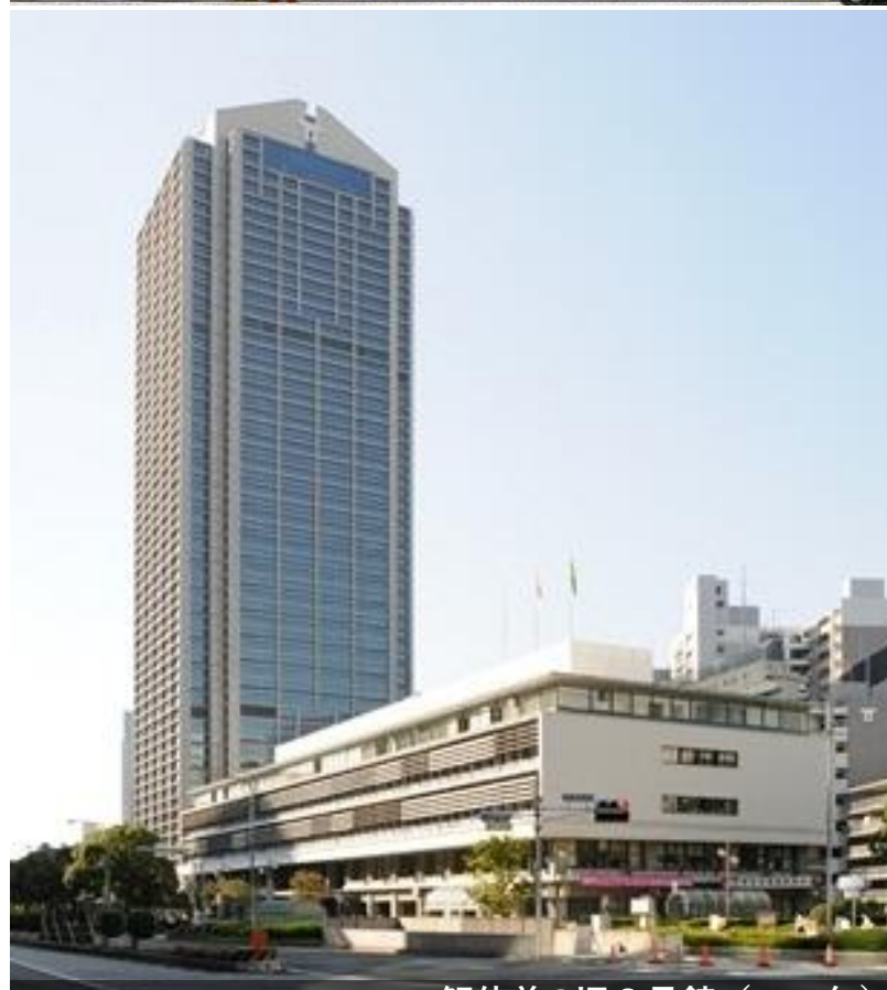
解体前の旧2号館（2018年）
